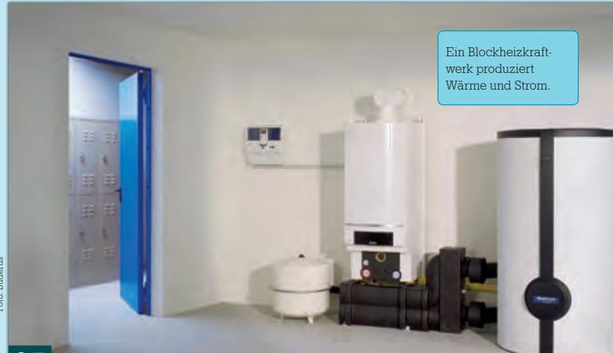
Ein Blockheizkraftwerk produziert Wärme und Strom.
